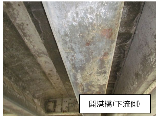
写真2 主桁の損傷
