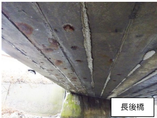
写真3 主桁の損傷
