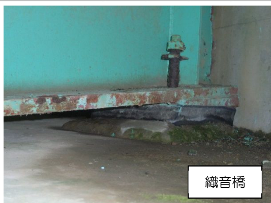
写真1 支承の損傷
