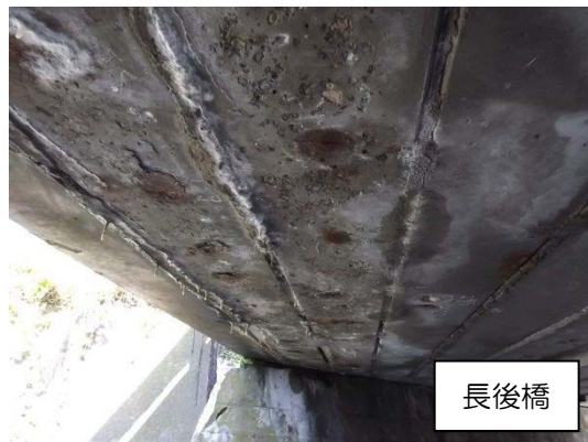
写真2 主桁の損傷
