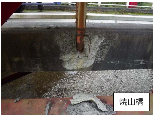
写真5 地覆の損傷
