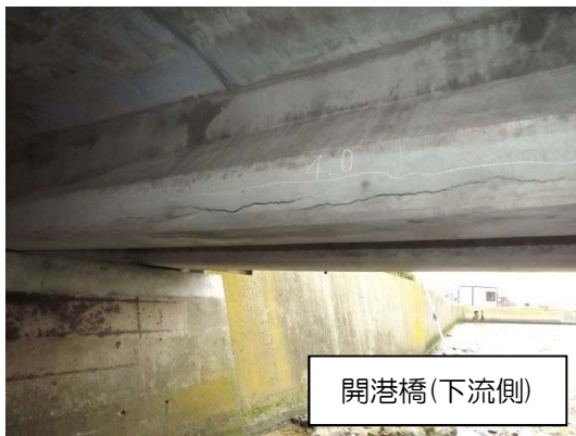
写真1 主桁の損傷
