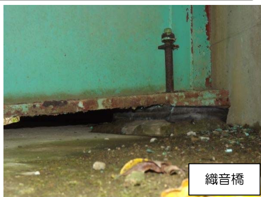
写真1 支承の損傷
