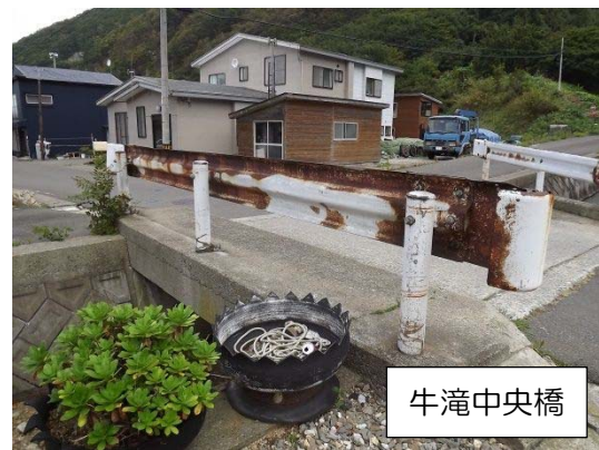
写真4 ガードレールの損傷
