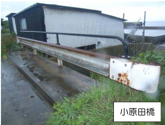
写真1 ガードレールの損傷
