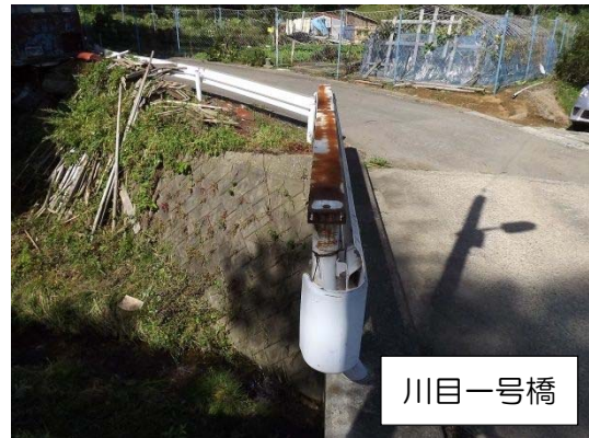
写真2 ガードレールの損傷
