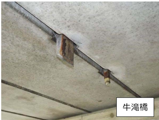
写真3 排水管の損傷
