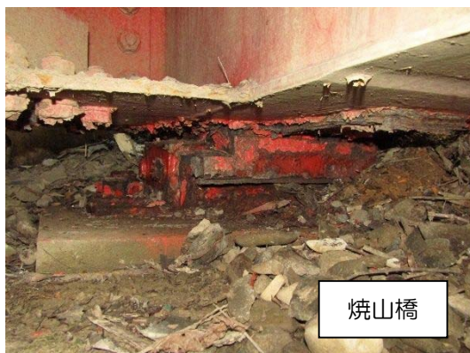
写真1 支承の損傷
