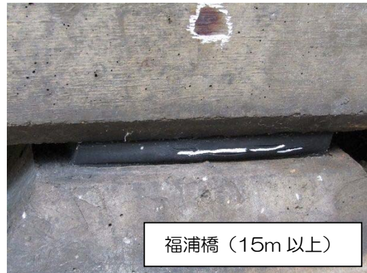
写真2 支承の損傷
