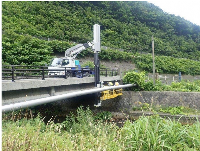
従来の点検方法（橋梁点検車）
