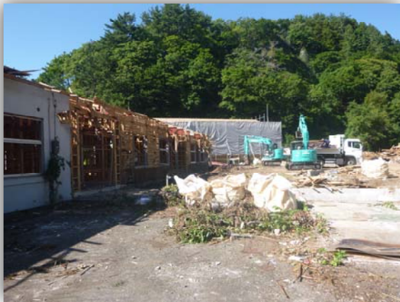
旧磯谷小中学校 解体除却
