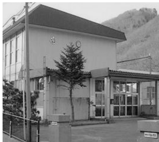
耐震補強が計画されている「牛滝小中学校（校舎）」
