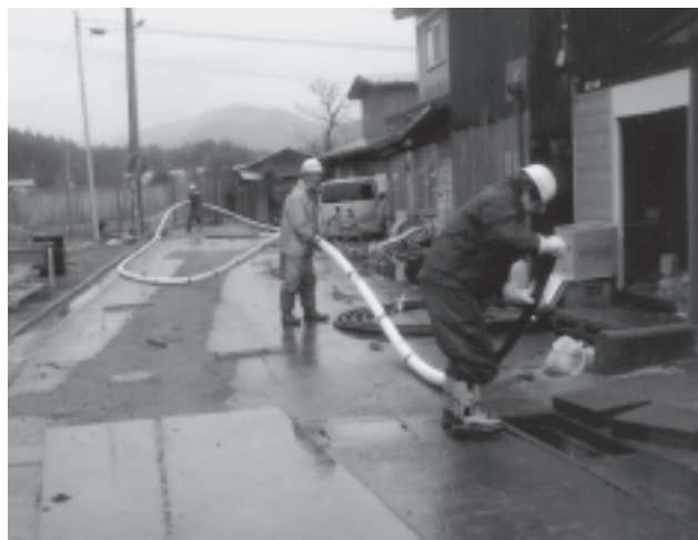
下水道工事に合わせて実施した配水管布設替え工事 （古佐井地区）
