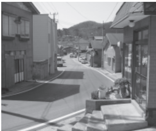
下水道管の布設は古佐井浜町付近で終了
