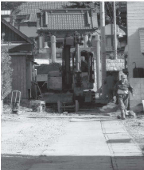
昨年の古佐井地区の下水道管布設工事
