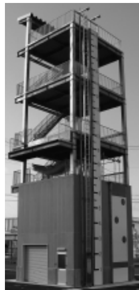
消防センター訓練棟
