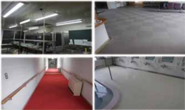
※改修後の高齢者生活福祉センター
