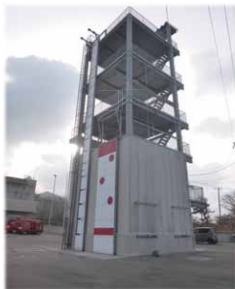
※改修後の消防訓練塔
