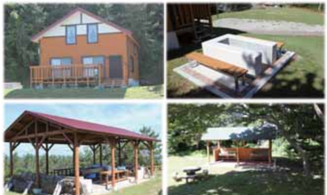
※改修後の願掛公園野営場
