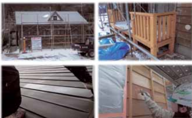
※工事中的の大佐井新町団地
