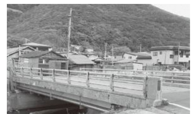
架け替え工事が行なわれる牛滝開港橋
