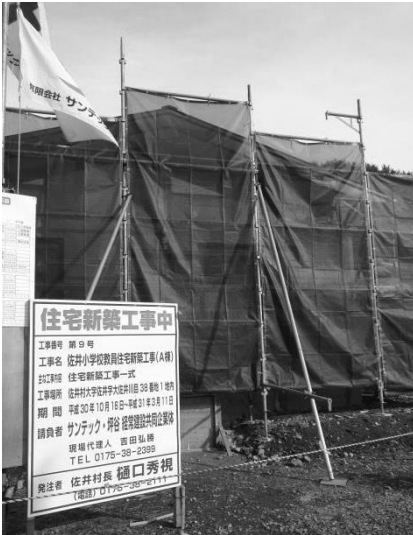
旧森林管理署（営林署跡地）に 建設中の佐井小学校教員住宅
