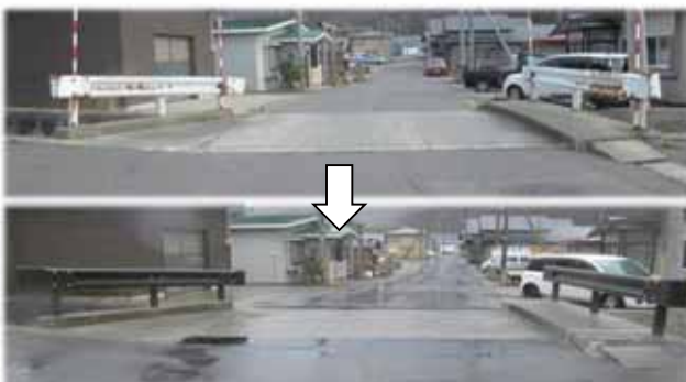
※補修された牛滝中央橋
