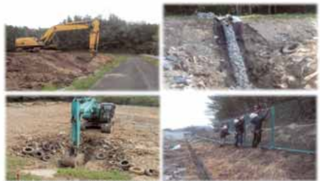
※不燃物埋立最終処分場整地工事
