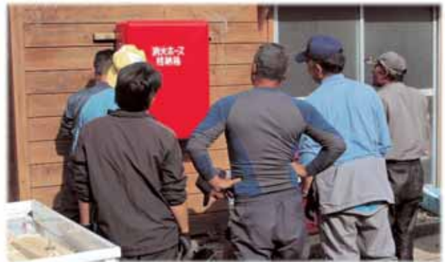
※消火栓用格納箱設置作業
