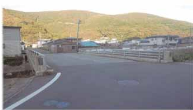
※牛滝地区開港橋(令和2年度着工)
