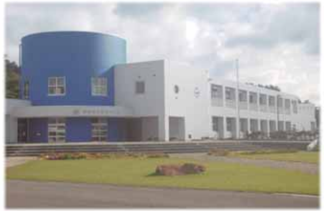
※改修後の佐井中学校
