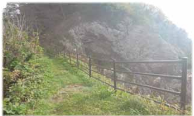
※願掛公園遊歩道手すり改修工事
