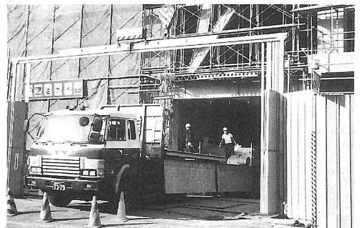
(有)ナカケイ工業の作業現場
