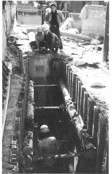
(有)柴田工業の作業現場
