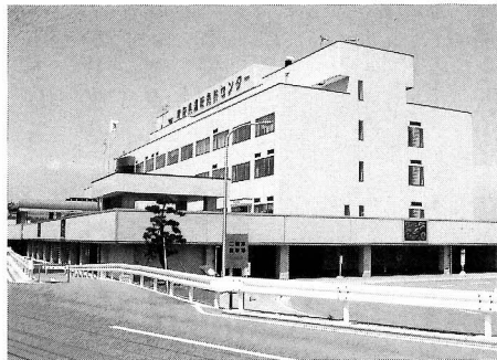
●センター建物全景
