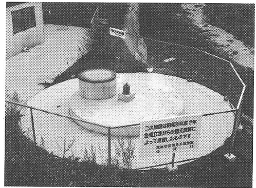
◀ 長後地区簡易水道
