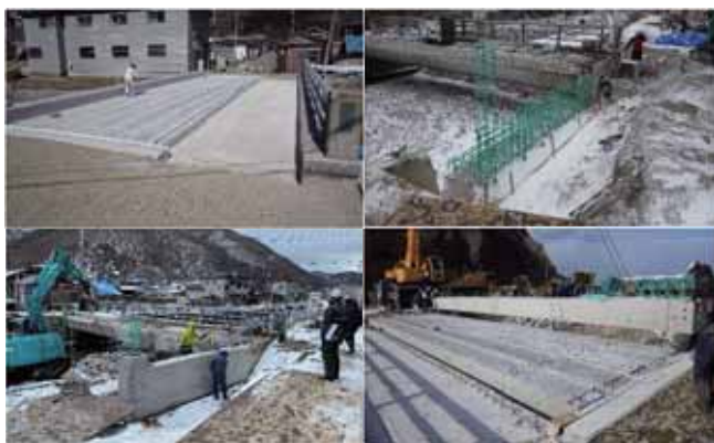
※牛滝開港橋(下流側)の工事の様子
