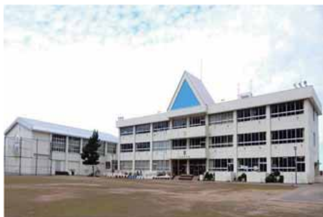
※佐井小学校の外観
