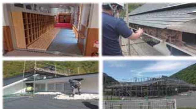
※歌舞伎の館改修工事写真
