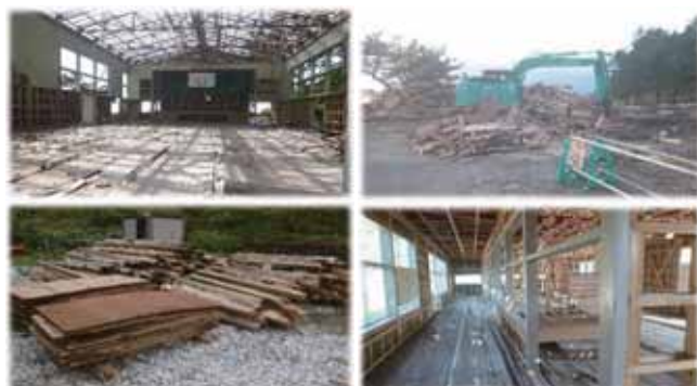
※旧磯谷小中学校解体工事写真
