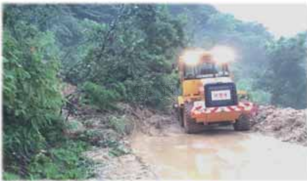
※村道福浦川目線復旧作業
