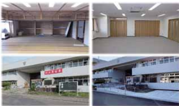
※和室および正面玄関の改修前後
