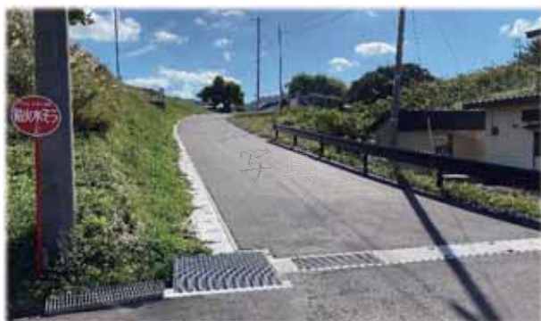
※改良工事を行った村道原田小学校線
