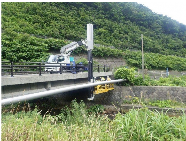
従来の点検方法（橋梁点検車）
